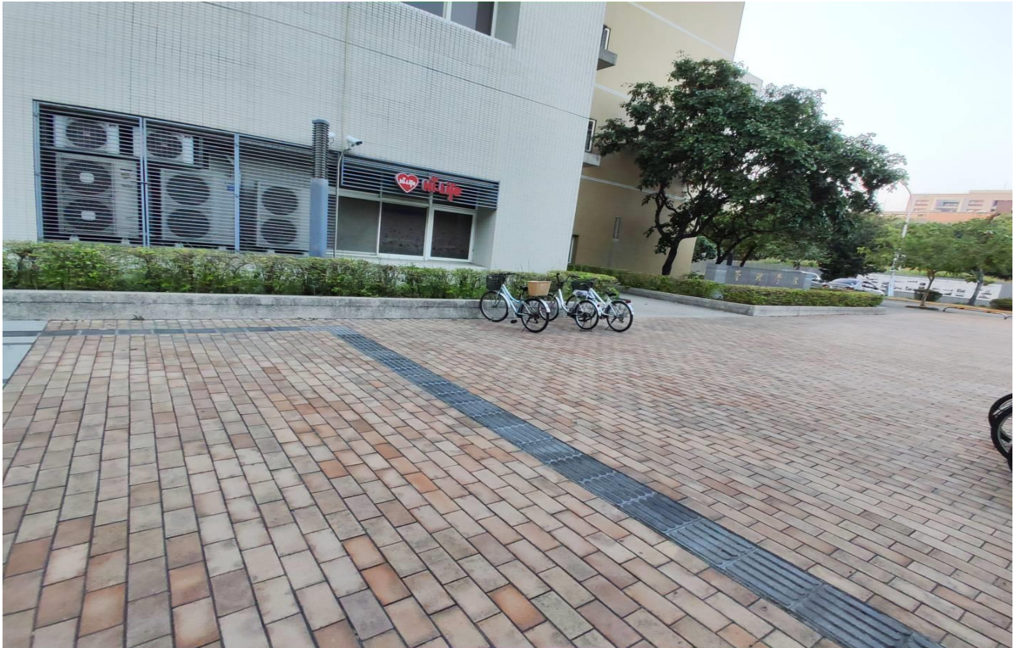
大樓外紅磚區-北側
